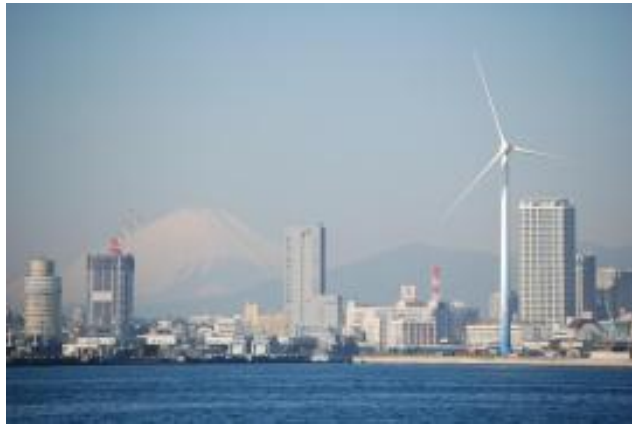
横浜市風力発電所（ハマウイング）
